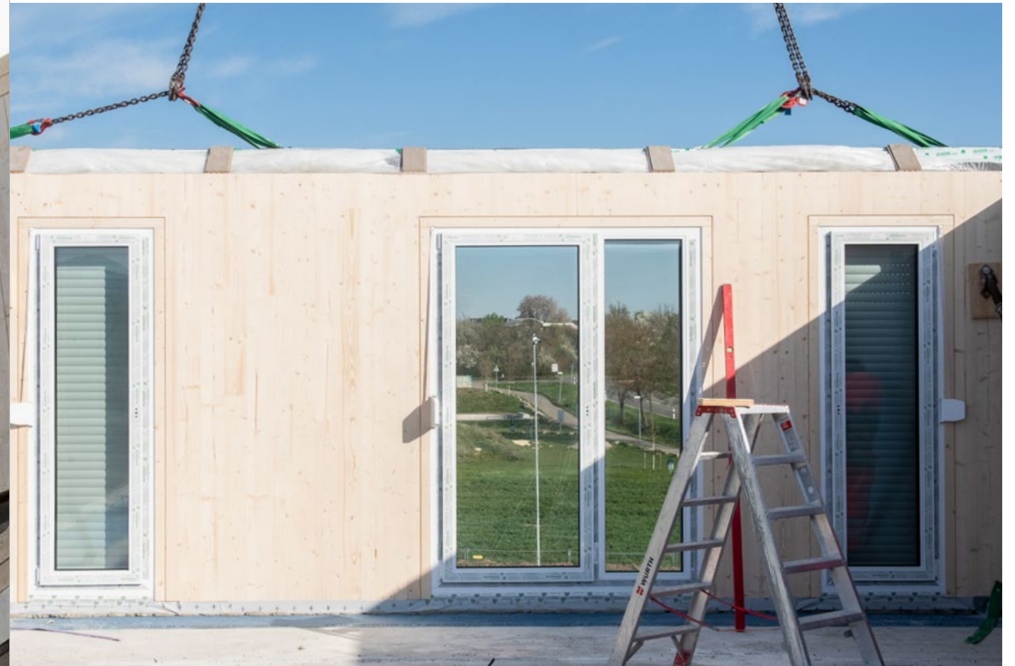
Innenansicht des Außenwandelements bei Montage, Quartier Hangweide, Kernen © ZÜBLIN Timber
