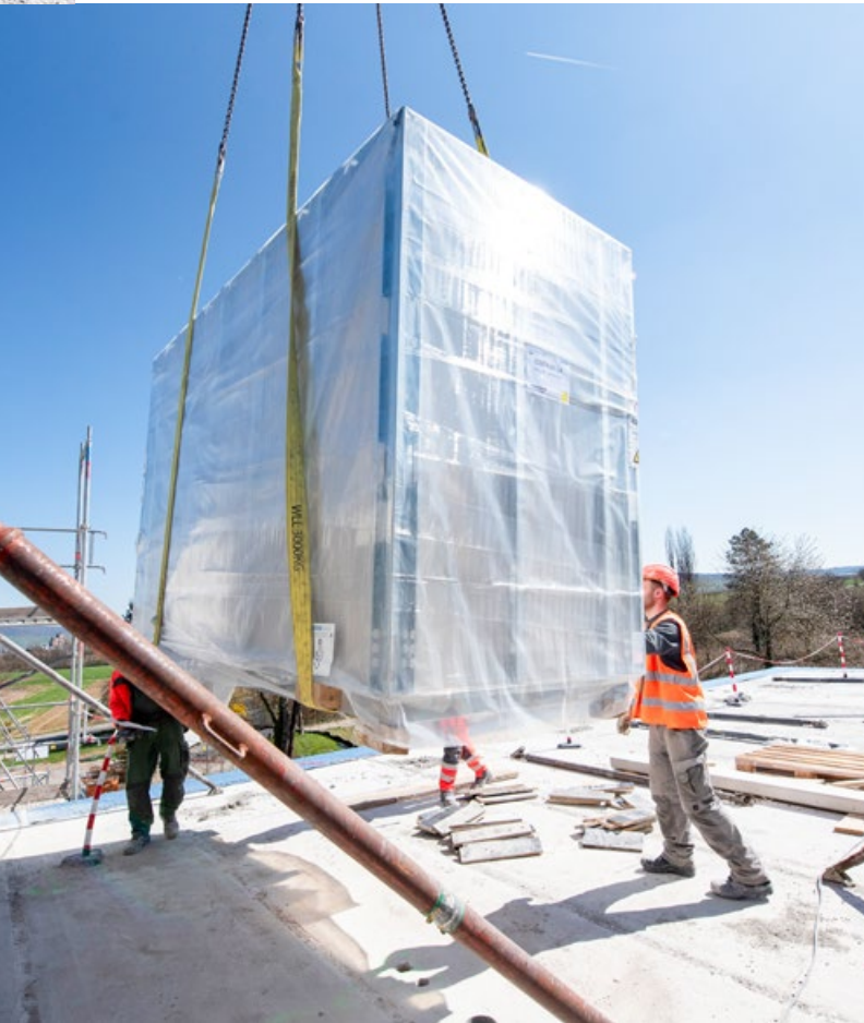
Montage des Bad-/TGA-Schachtmoduls, Quartier Hangweide, Kernen © ZÜBLIN Timber
