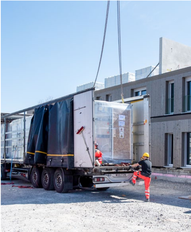
Anlieferung des Bad-/TGA-Schachtmoduls, Quartier Hangweide, Kernen © ZÜBLIN Timber
