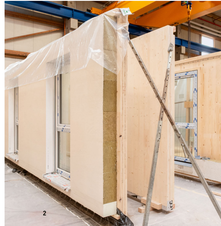
2 Vorfertigung der LENO®-ADD-Außenwandelemente, © Sandra Sitzmann / ZÜBLIN Timber
