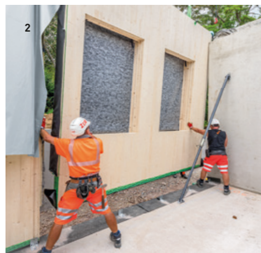
1 LENO®-ADD-Wandaufbau © Ed. Züblin AG 2 Lieferung eines LENO®-ADD-Außenwandelements © Ed. Züblin AG
