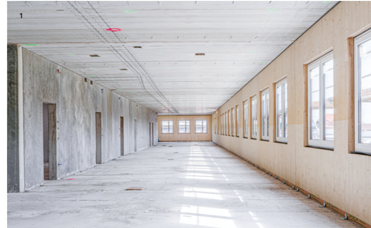
1 Rohbau AktivSchule, Erleben © Ed. Züblin AG
