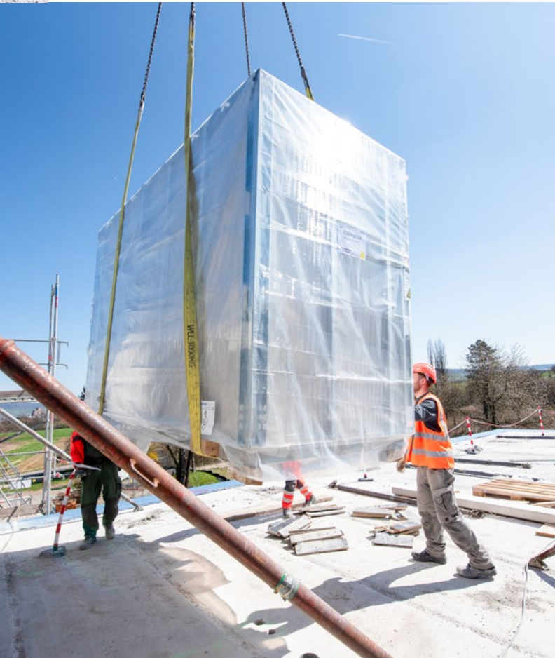
Montage des Bad-/TGA-Schachtmoduls Quartier Hangweide, Kernen © ZÜBLIN
