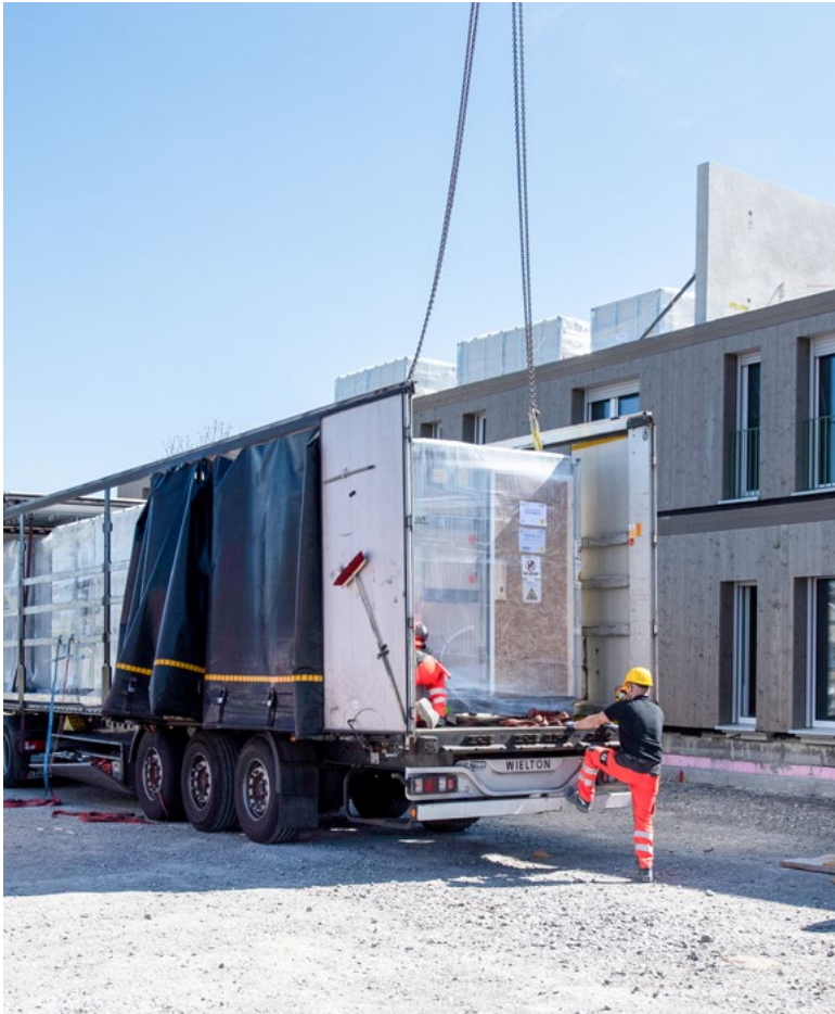
Anlieferung des Bad-/TGA-Schachtmoduls Quartier Hangweide, Kernen © ZÜBLIN
